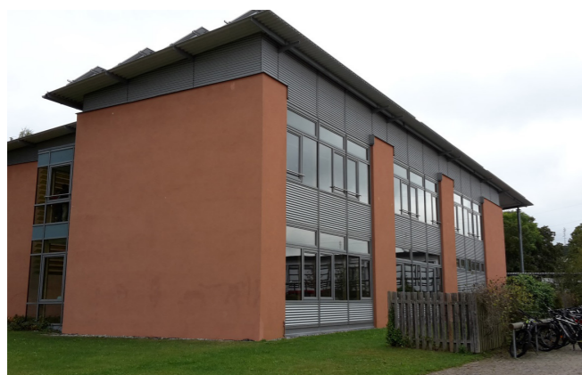
Das Klassenzimmer der KBS-Schüler befindet sich im zweiten Stock des Erweiterungsbaus.
